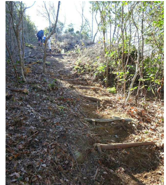
手製の材料でも階段を設置
