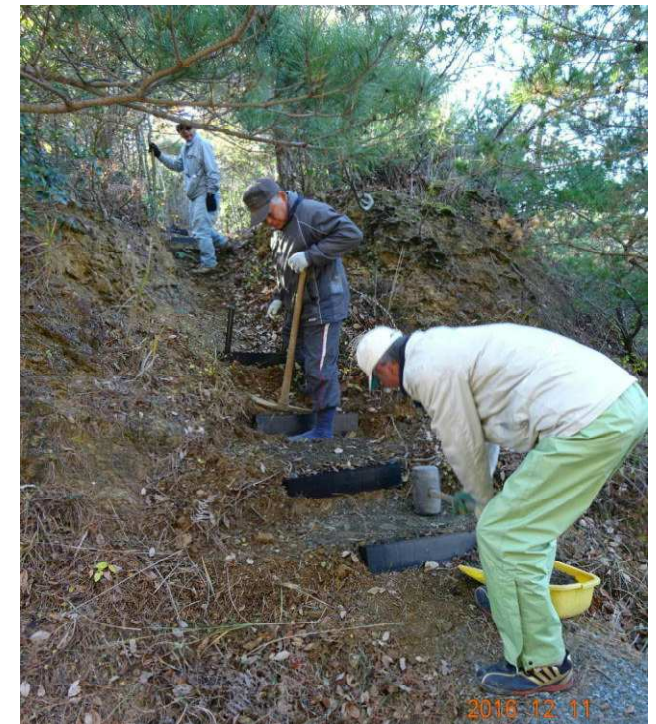
出丸への降り口に階段を設置
